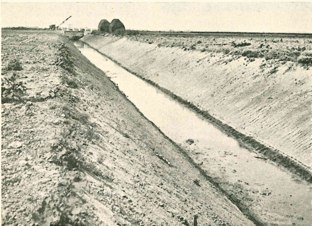
CONTROFOSSA DESTRA DEL FIUME ALBEGNA A VALLE DELLA STRADA AMIATINA.
