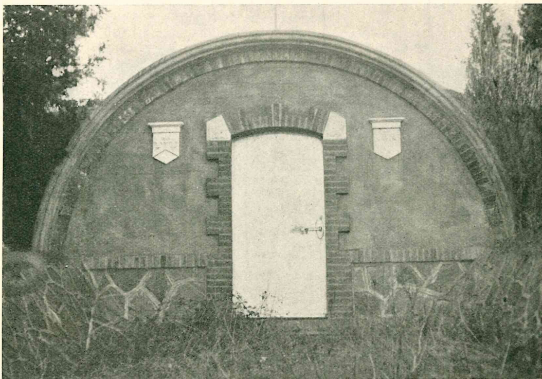
ACQUEDOTTO RURALE PER L'ALIMENTAZIONE DI SEI PODERI DELLA CAPACITÀ DI MC. 75. (Tenuta di Poggio Cavallo - Grosseto - Propr. Andreini).
